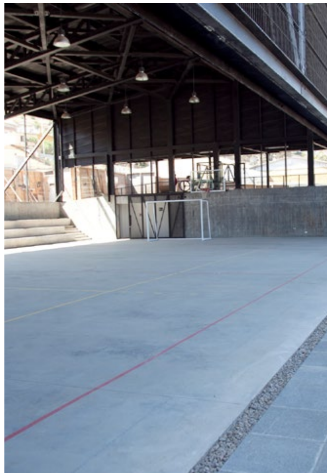
CENTRO DEPORTIVO COMUNITARIO LA AGUADA, ILLAPEL
