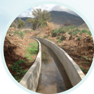
REVESTIMIENTO CANAL MOLINO DE PERALILLO
