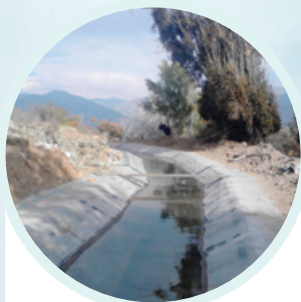
REVESTIMIENTO CANAL EL BOLDO
